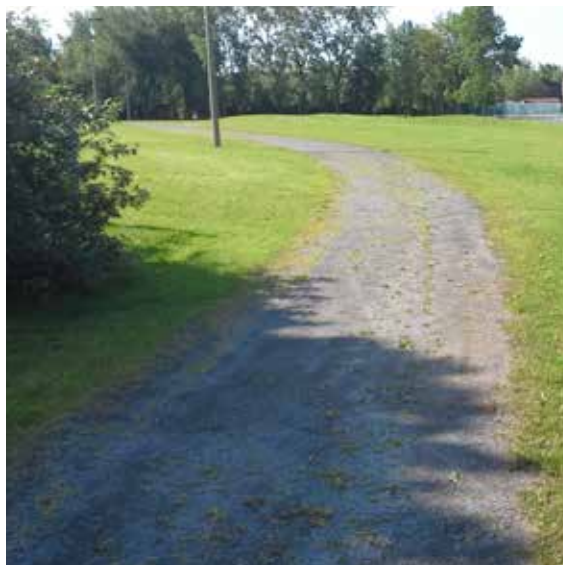
Sentier polyvalent qui présente une surface de roulement usée
